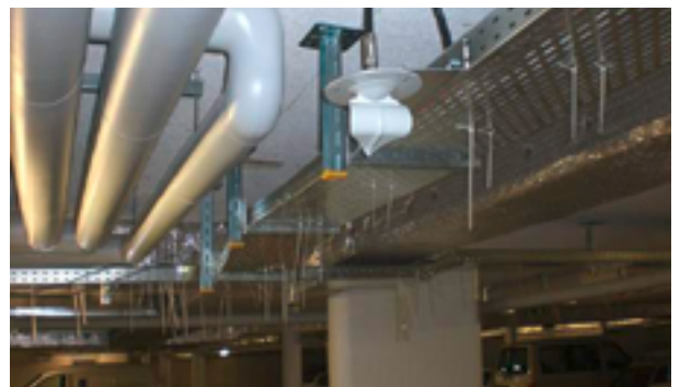
Les antennes assurent la couverture dans les moindres recoins du bâtiment.
